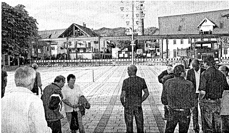
Die »Offene Halle« bei der »Alten Fabrik« wird gerade errichtet, doch die Einweihung der »Neuen Ortsmitte« ist erst einmal auf nächstes Jahr verschoben: Auch der für die Feierlichkeiten im Haushalt festgesetzte Ansatz in Höhe von 5000 Euro ist gesperrt. Das Thema Haushaltssperre sorgte am Montag bei der Gemeinderatssitzung für einen regen Besucherandrang. Foto: Andrea Bohner
